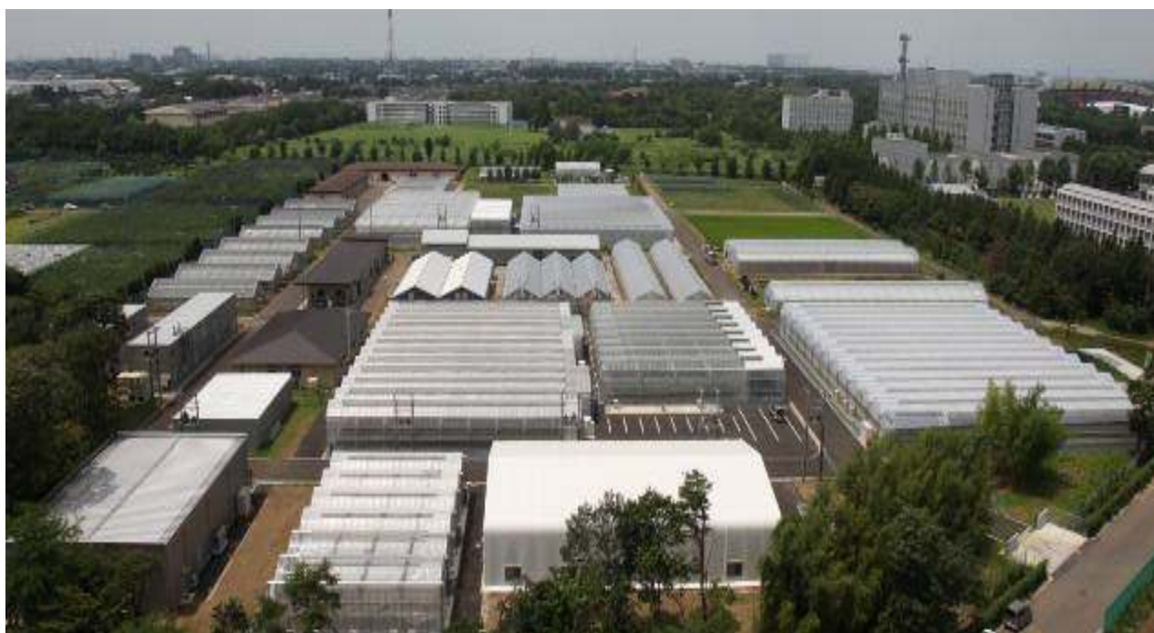
稼働中の千葉大学植物工場拠点（柏キャンパス）の俯瞰図
